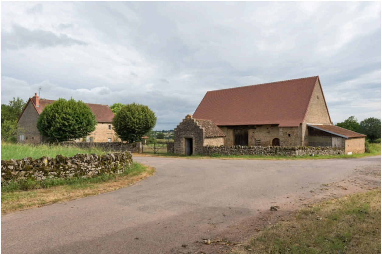
Vue d'ensemble d'une des fermes qui dépendaient du château, face à l'entrée de celui-ci
