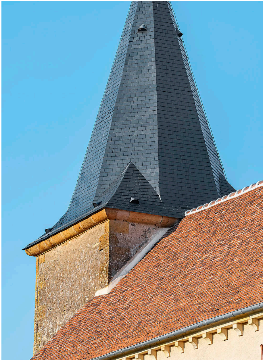
Détail de la couverture en tuiles plates refaite.
