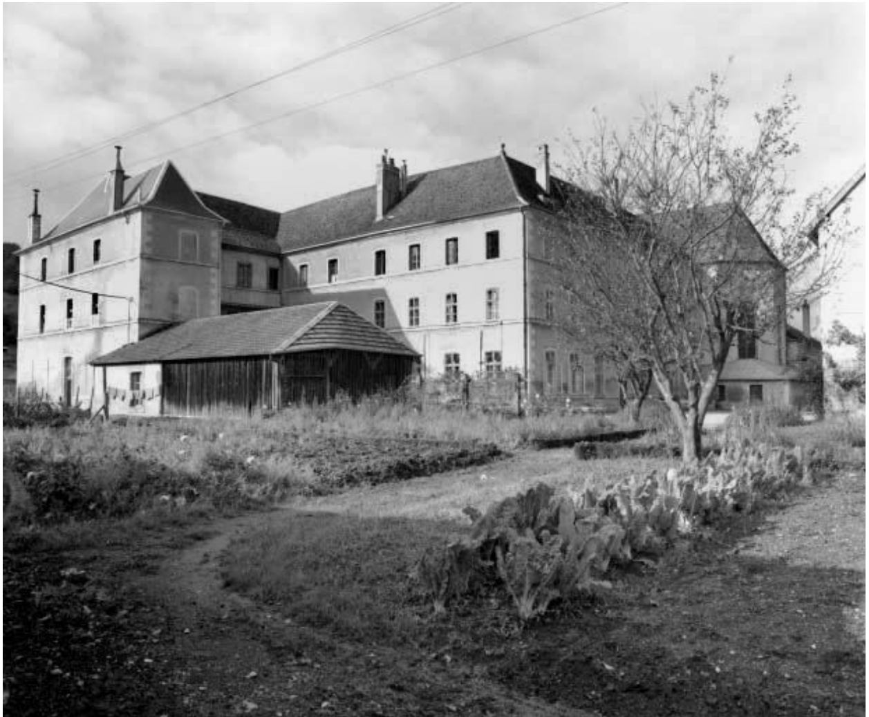
Vue d'ensemble des bâtiments depuis l'angle nord-est.
