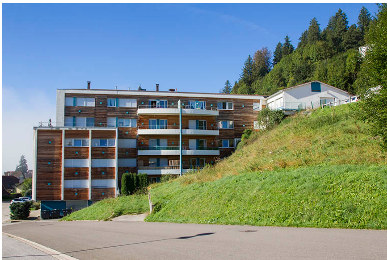
Façade latérale droite.
