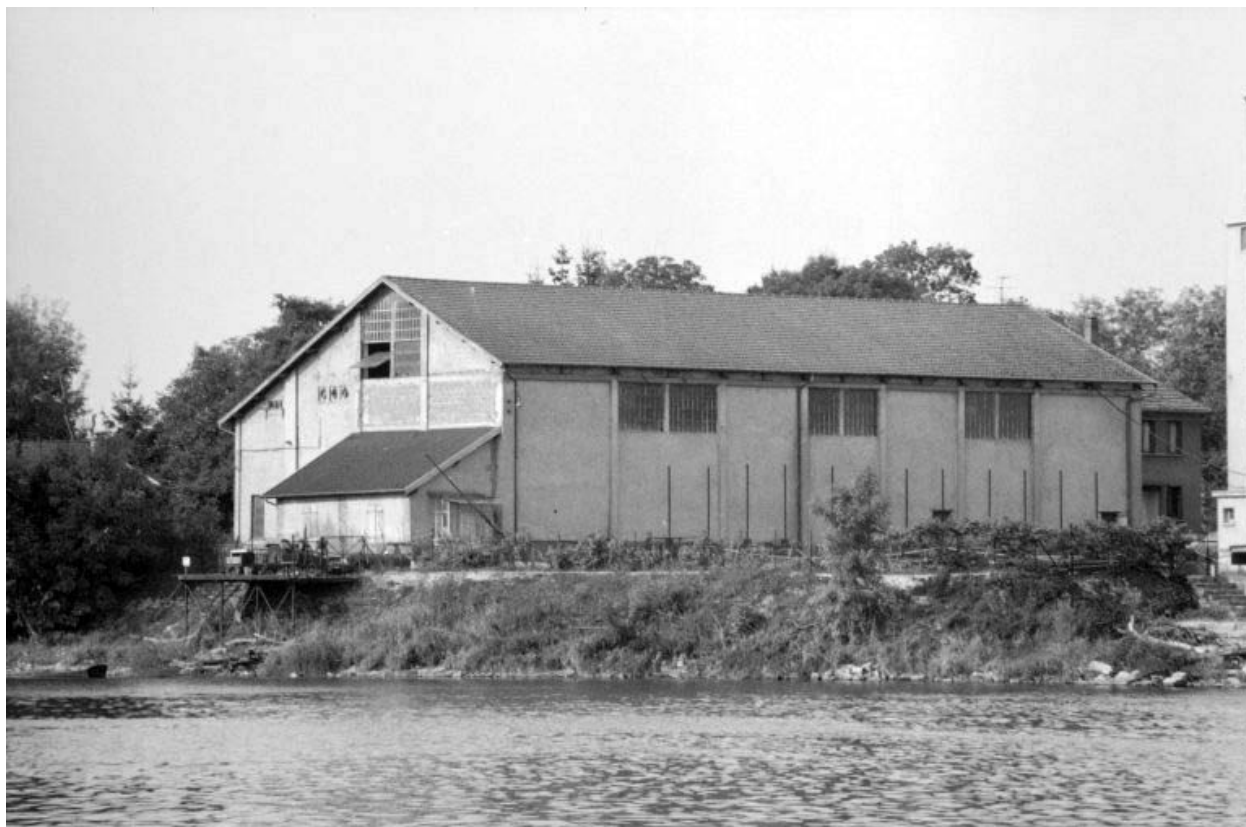
Centrale hydroélectrique, depuis l'est.
