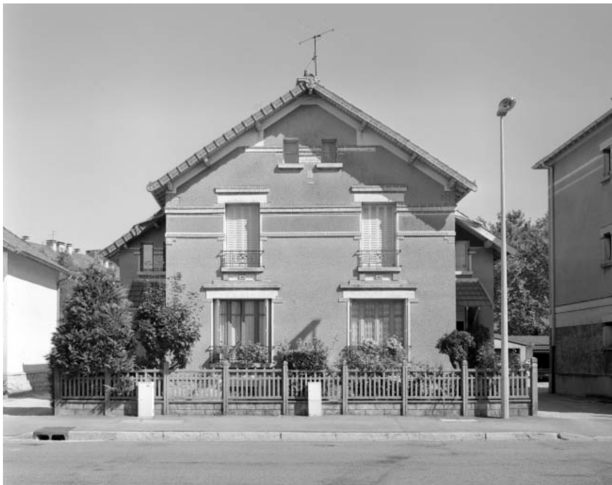
Façade antérieure d'un logement double (cadrage horizontal).
