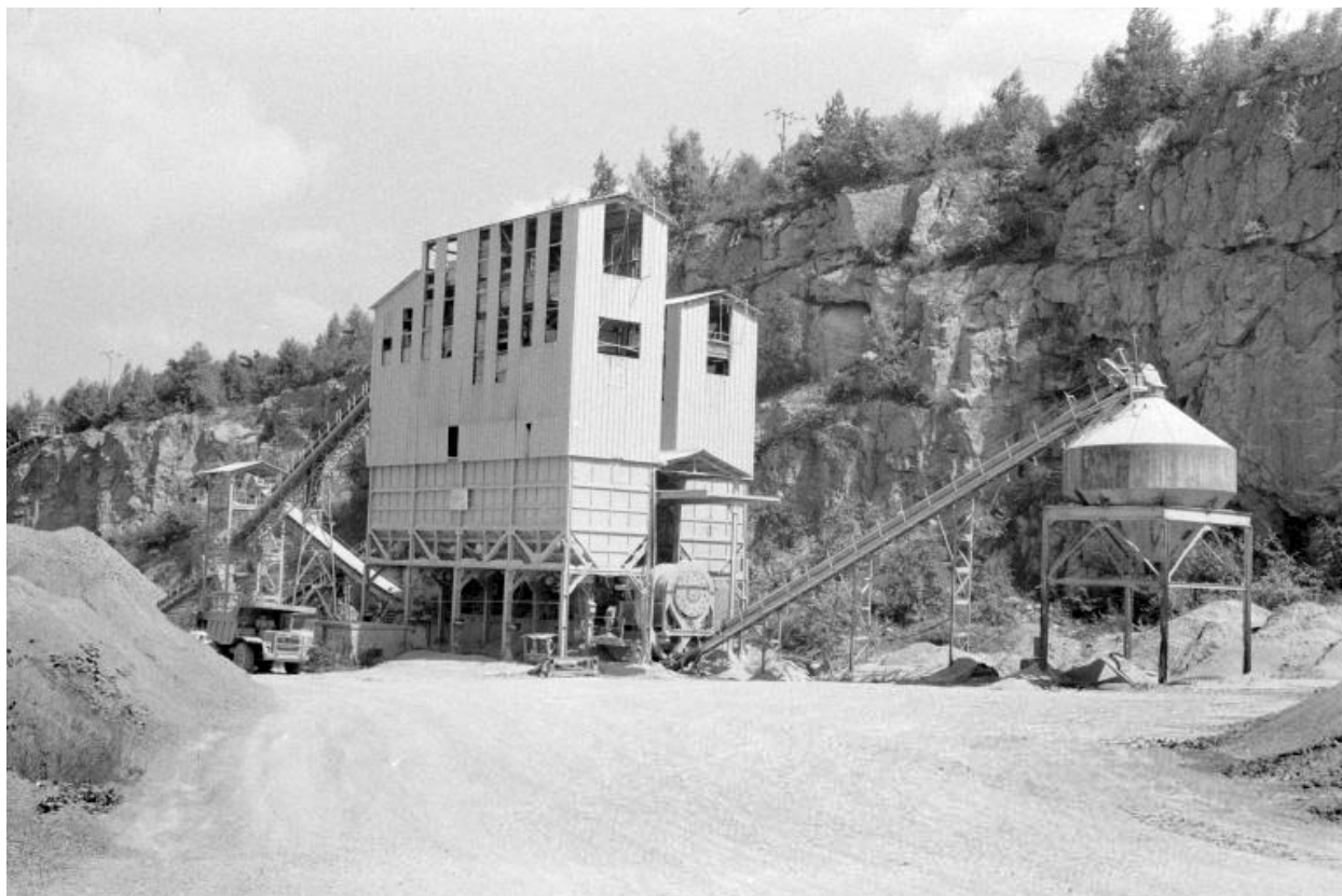
Nouvelles installations de concassage, en 1988.
