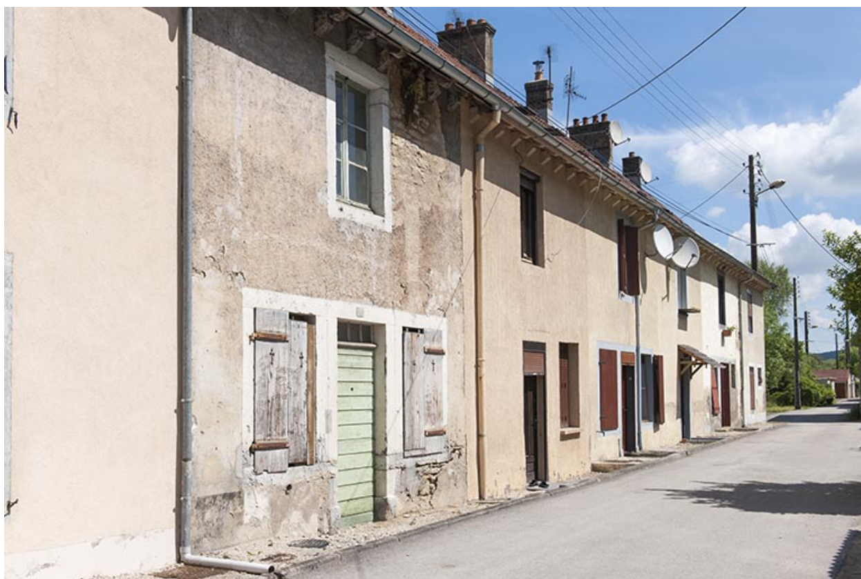
Façade sud d'un logement de type caserne.
