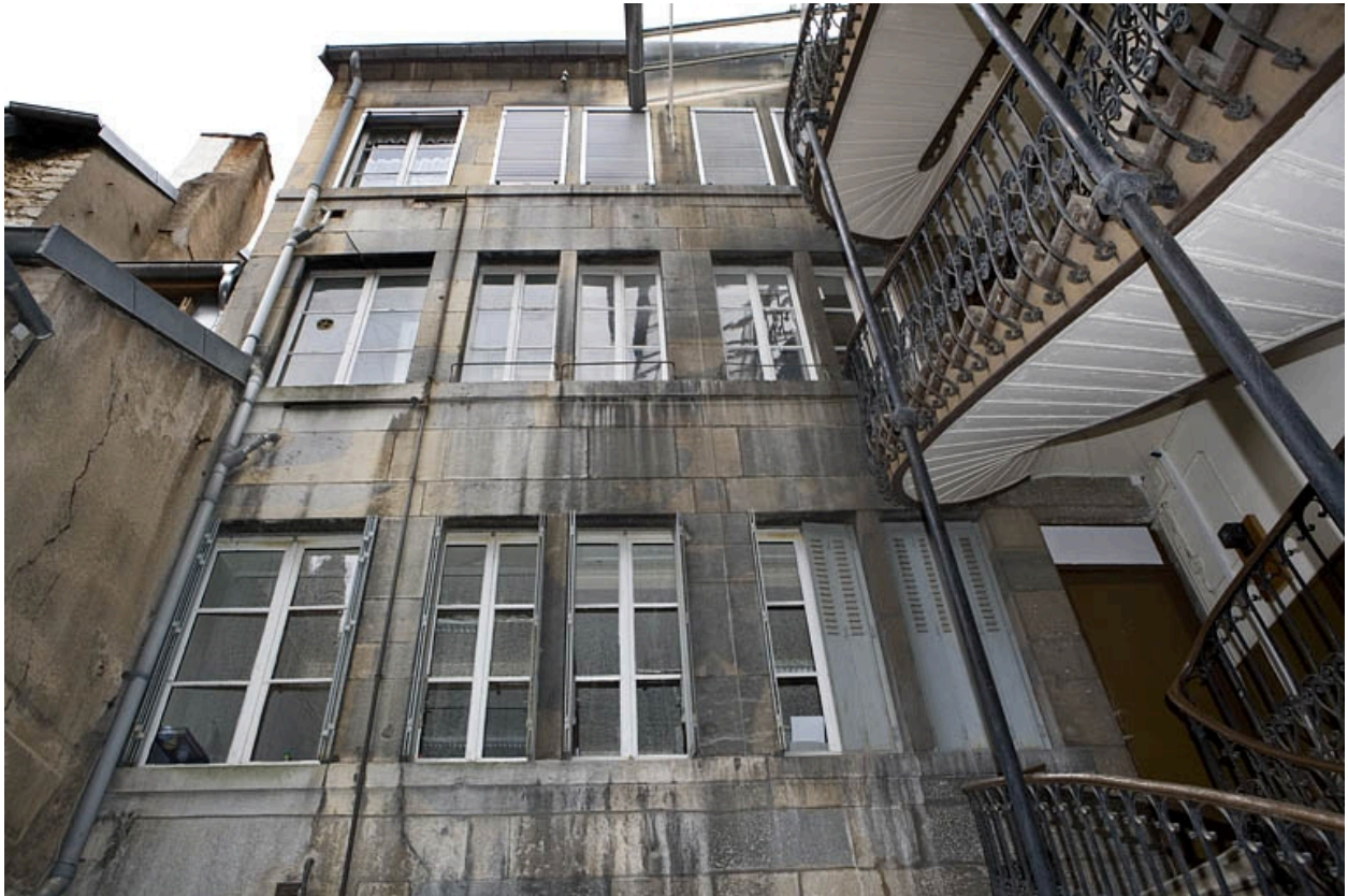
Détail de la façade postérieure du logis principal.
