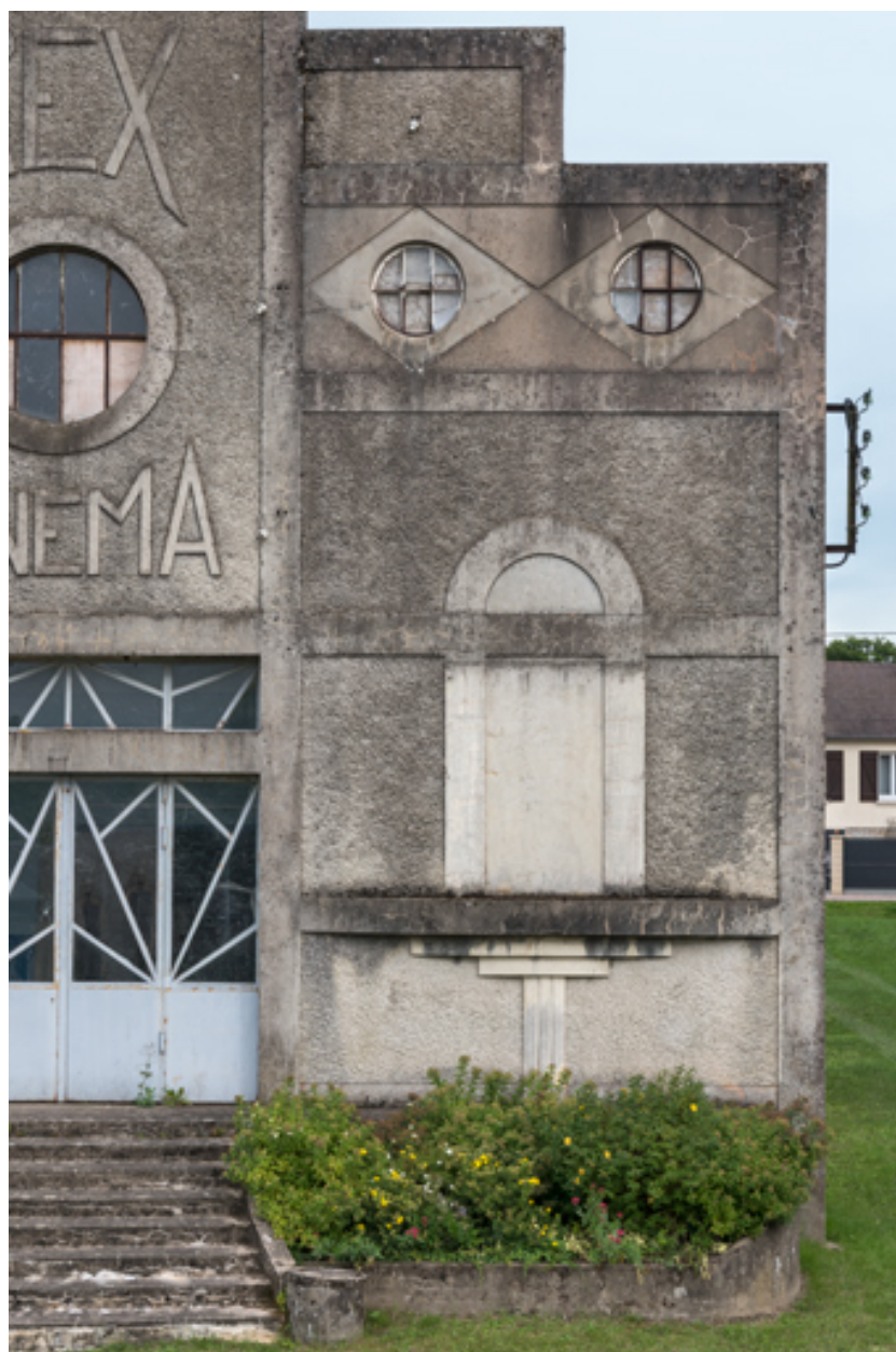
Façade antérieure : travée à droite.
