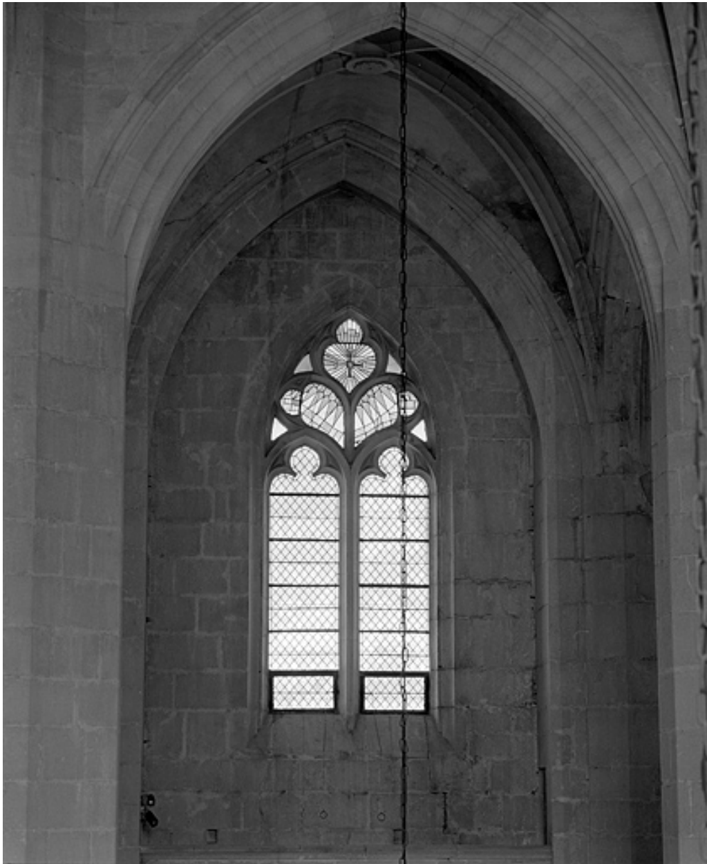
Baie de la sixième travée du collatéral nord.
