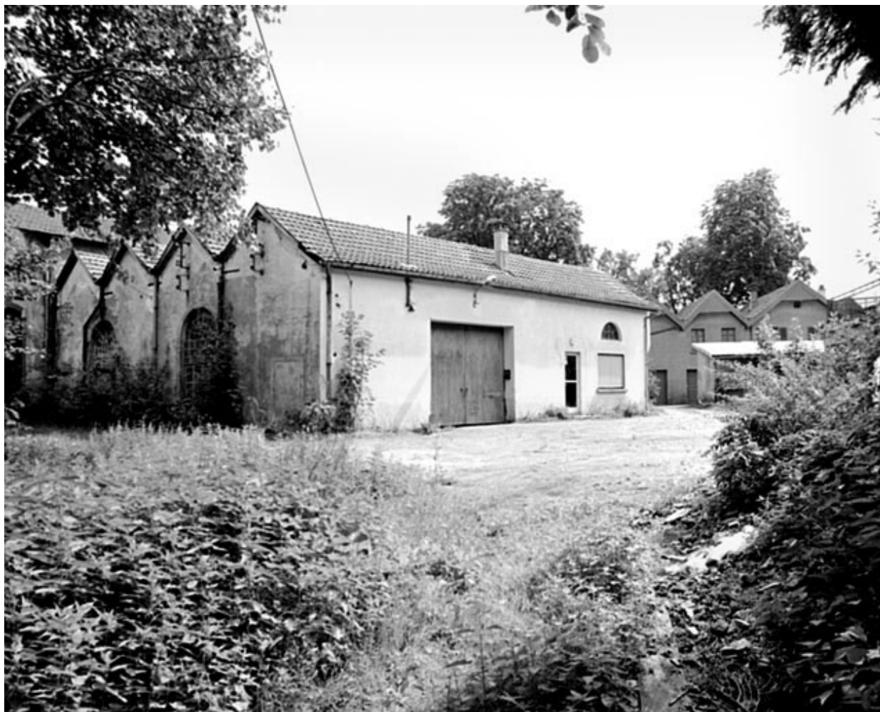
Salle des machines et chaufferie depuis l'ouest.
