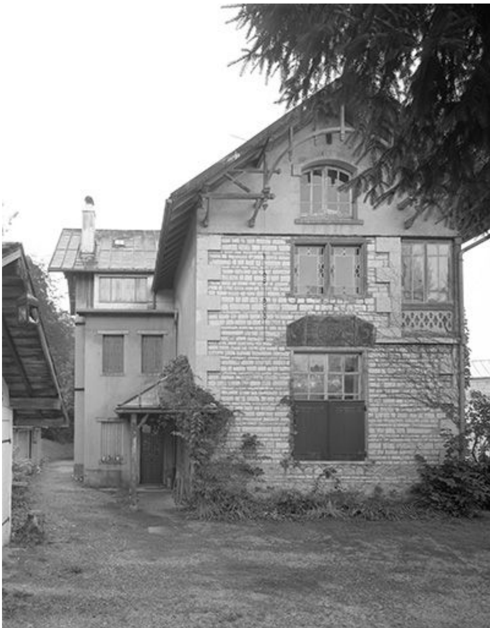
Vue rapprochée de la façade nord-ouest.
