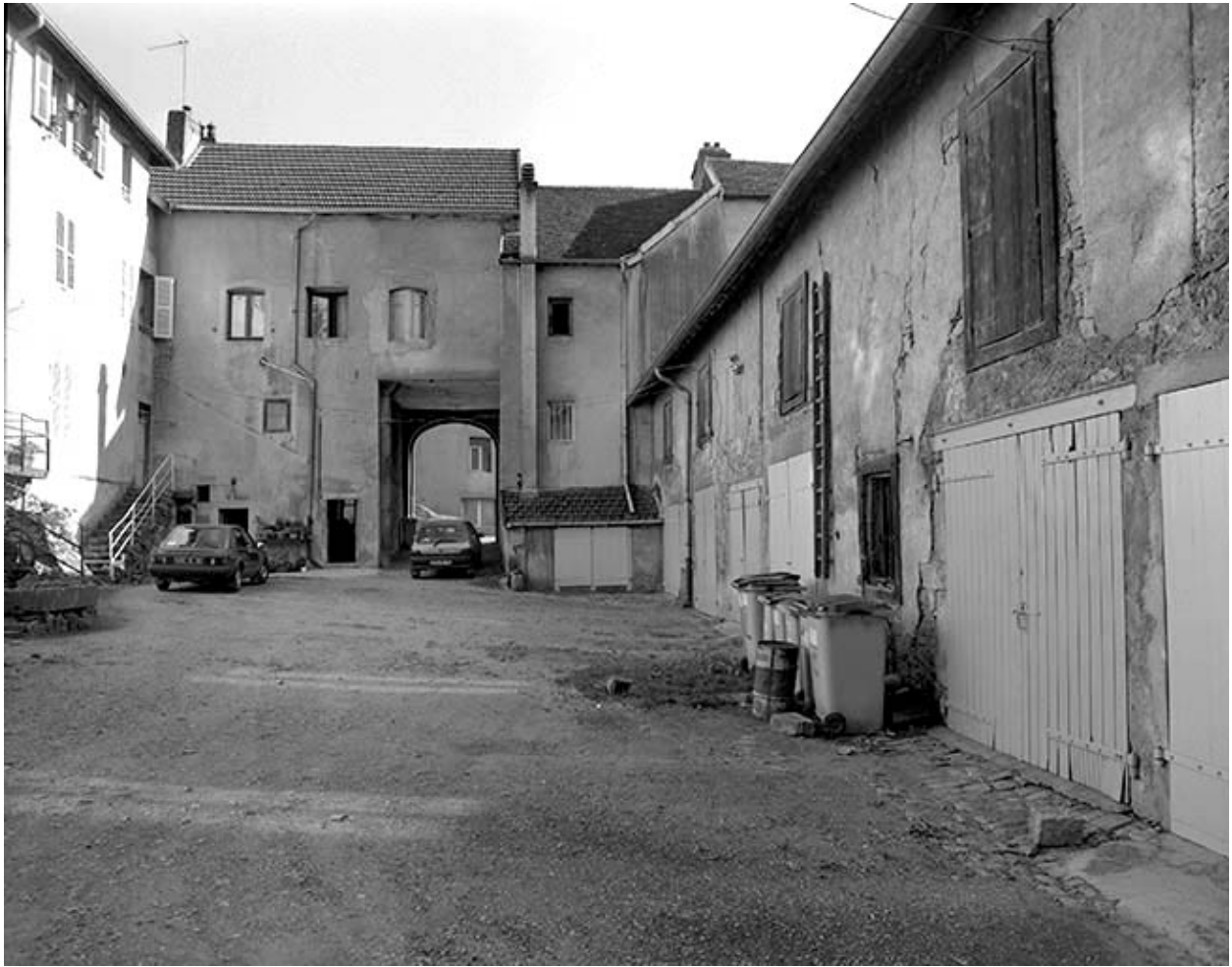
Cour du logement d'ouvriers.
