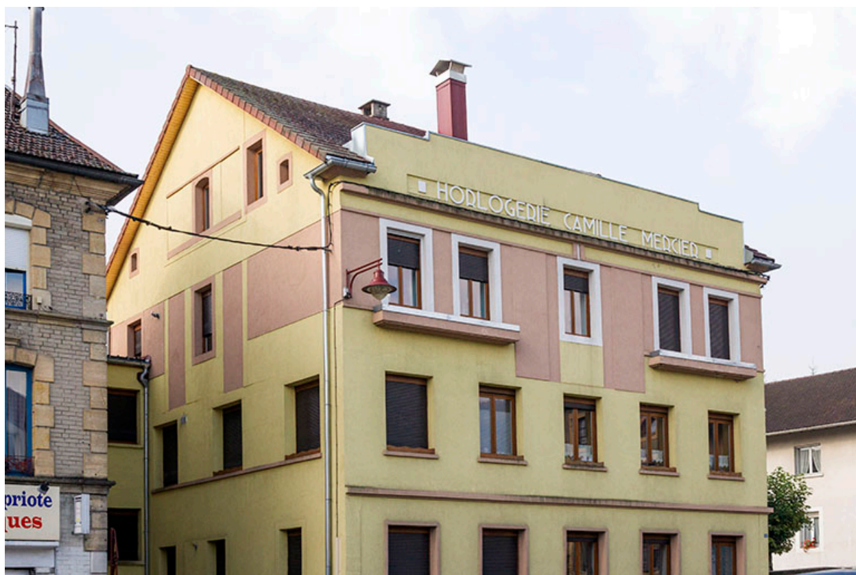
Immeuble : façades antérieure et latérale gauche.
