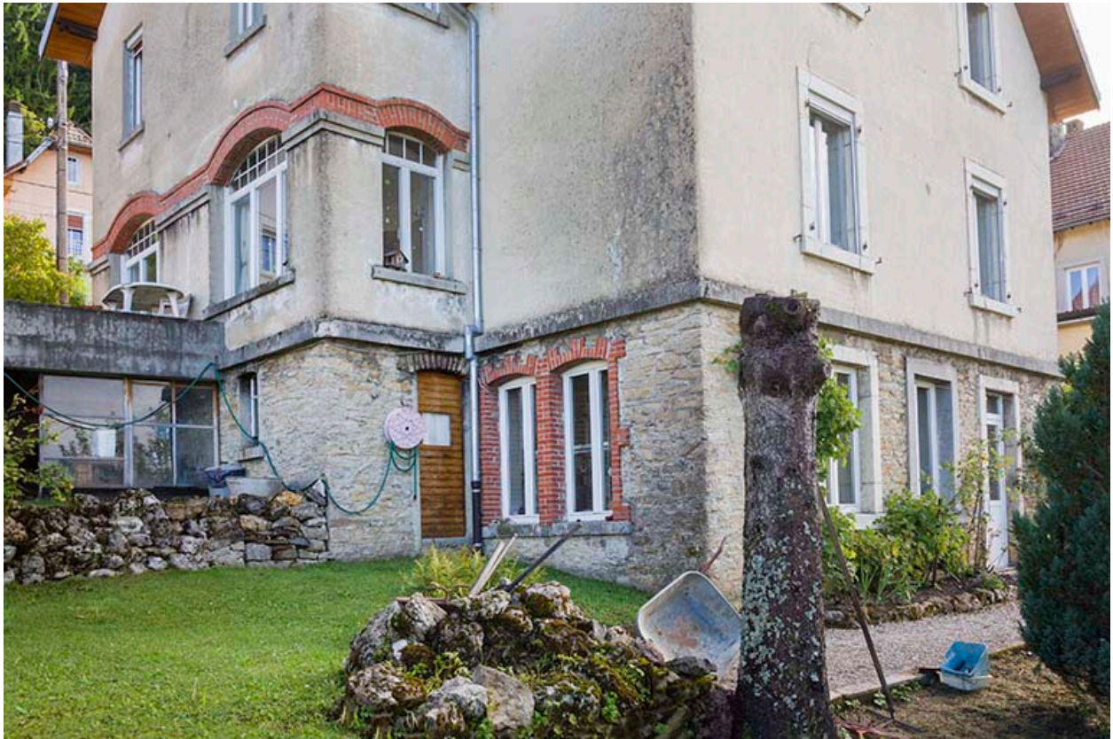
Façades postérieure et latérale droite : baies de l'atelier en soubassement.
