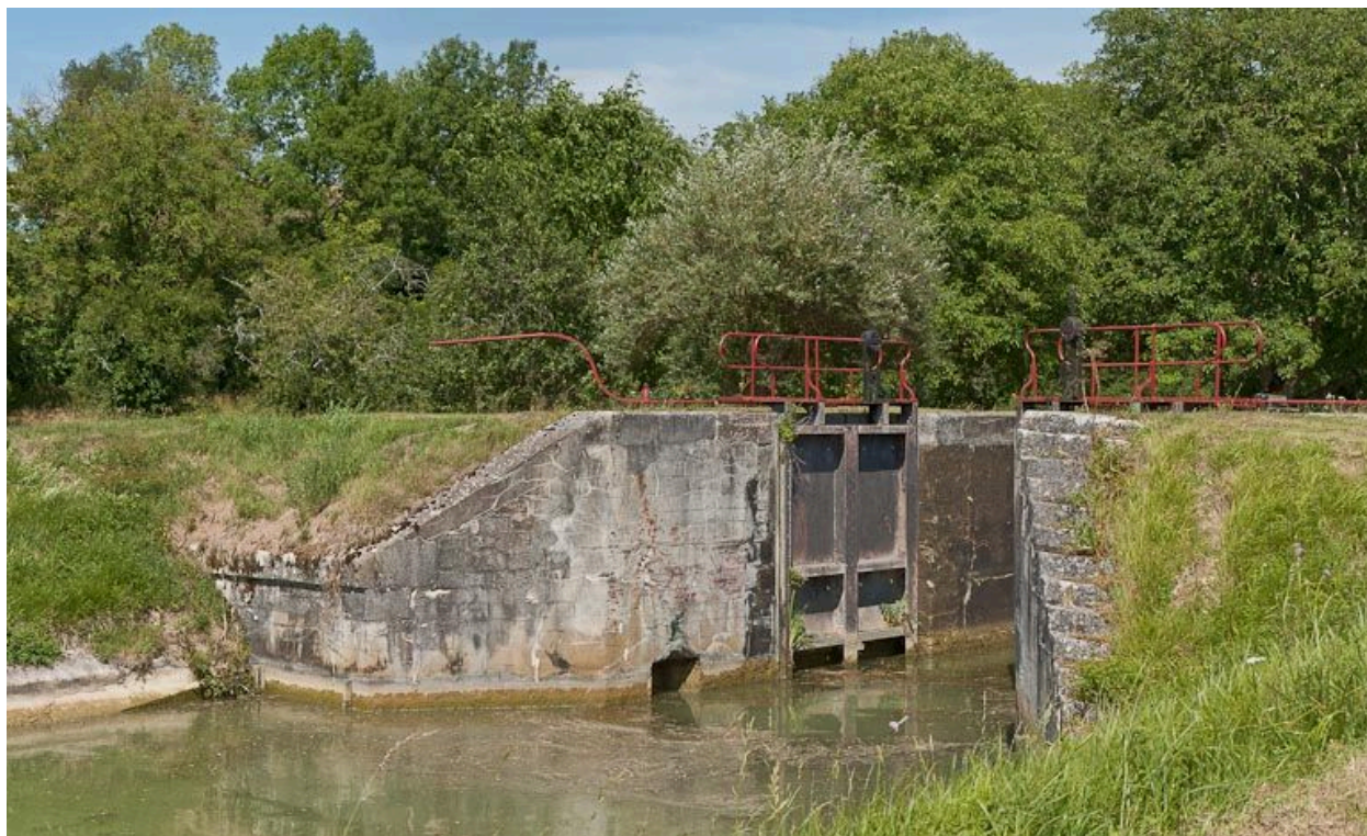
Vue du sas d'écluse en aval.
