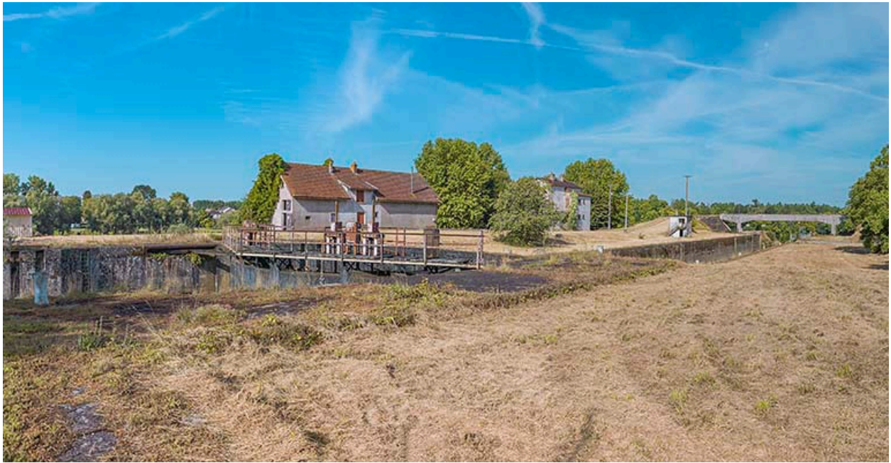
Vue d'ensemble du site d'écluse depuis l'amont.
