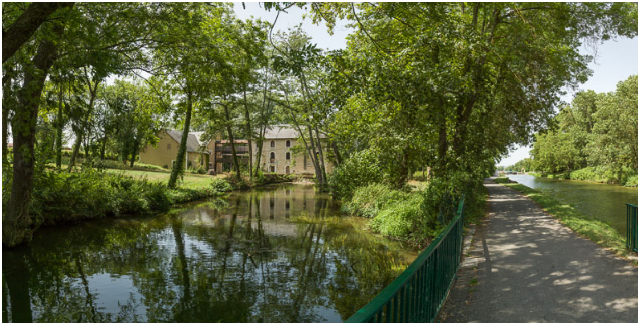
Vue d'ensemble du moulin avec à droite, le canal. Au premier plan, le bief de dérivation.
