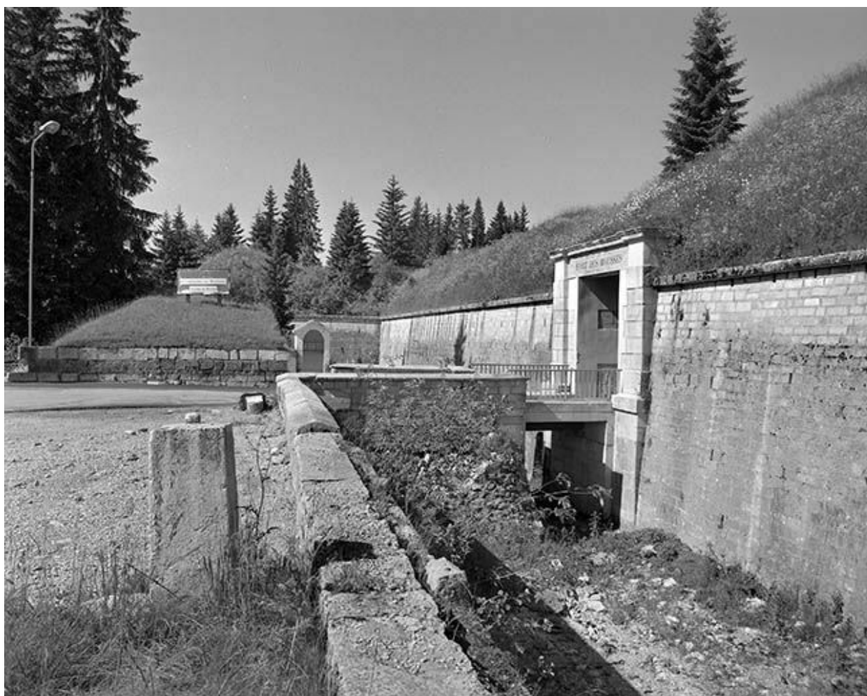
Porche d'accès au fort, fossé.
