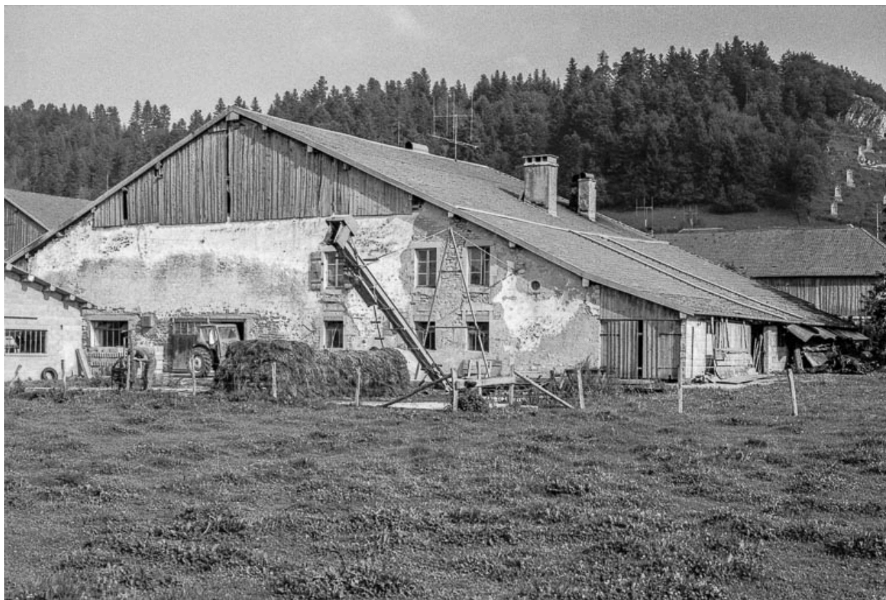
Ferme située 16 Grande Rue : façade postérieure.
