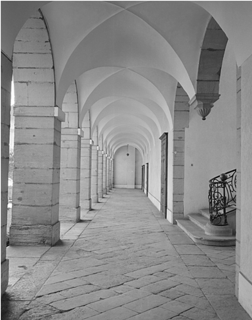
Galerie bordant la cour en rez-de-chaussée de l'aile gauche, avec départ du grand escalier.
