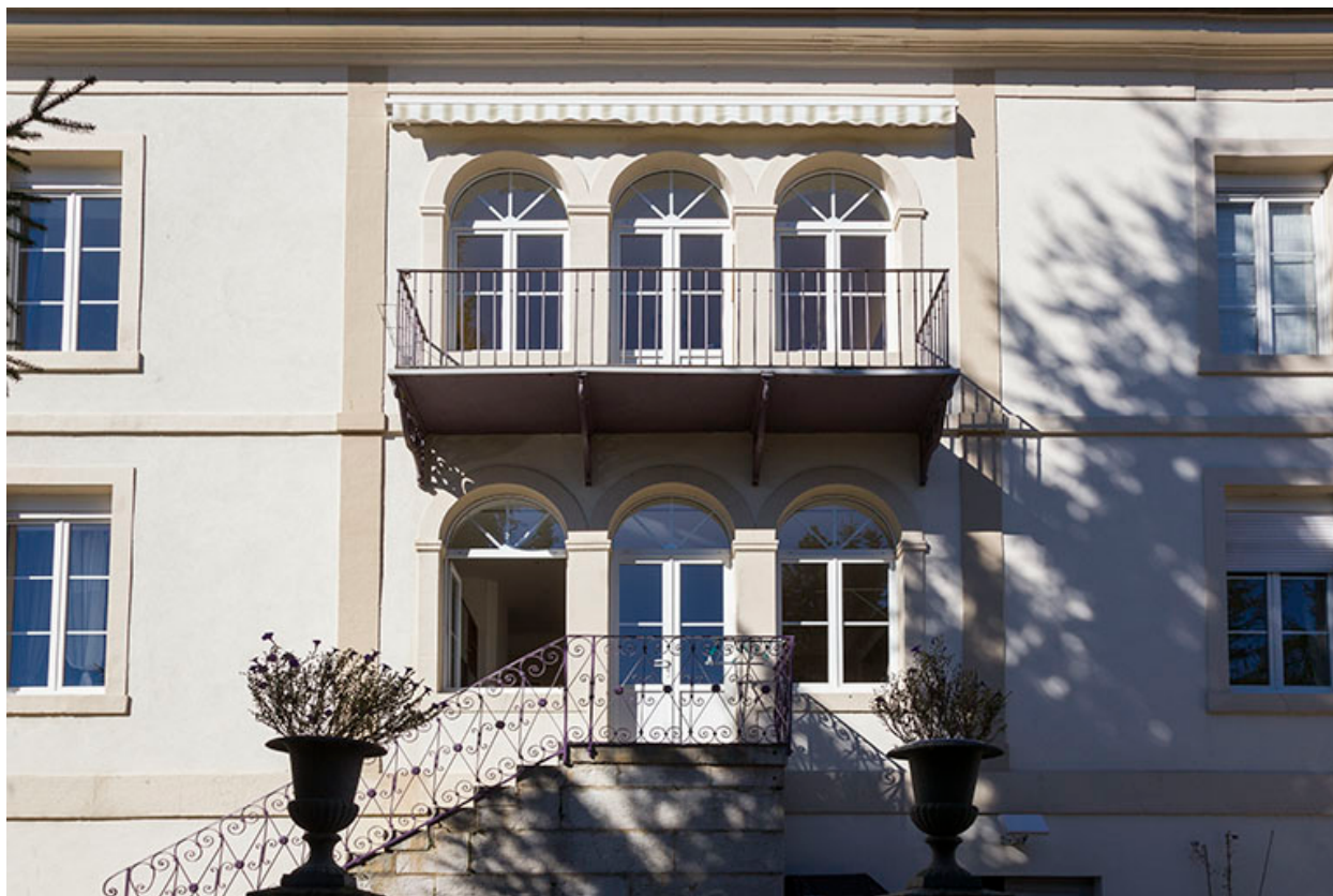
Façade postérieure : baies de la travée centrale.
