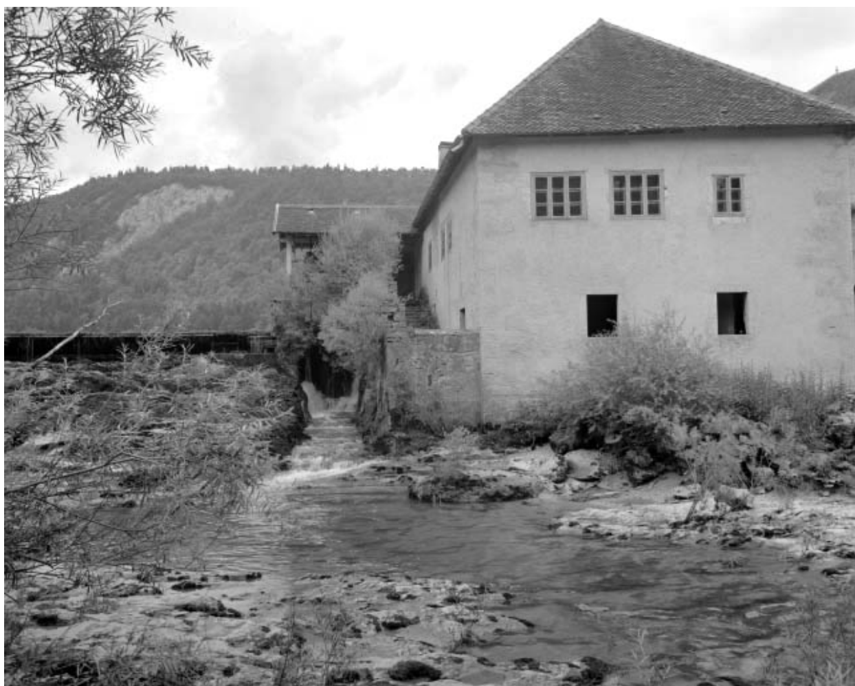
Vannes et scierie.
