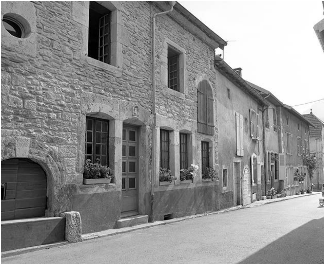
Maisons de la Grande Rue jusqu'à l'angle de la rue de l'Eglise.
