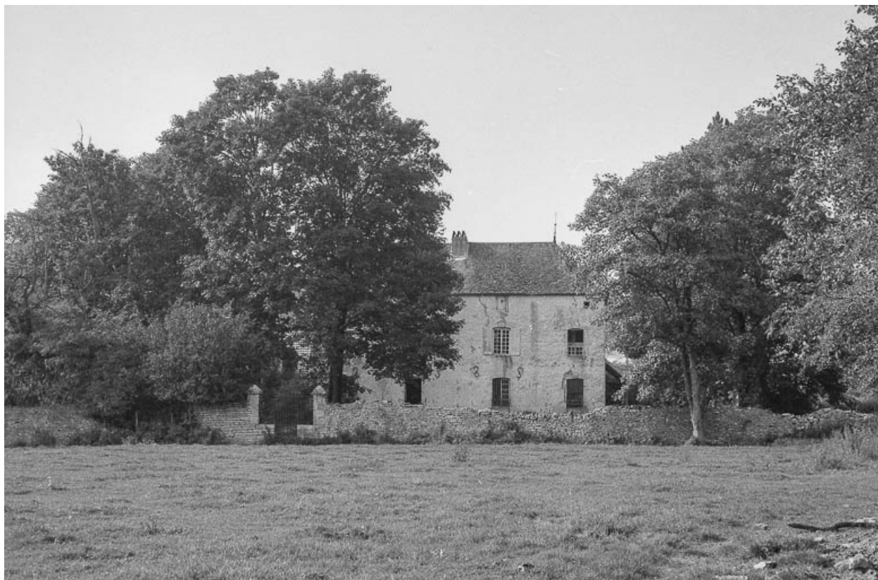
Façade sur le parc.
