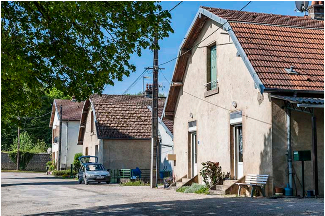
Pignons des logements ouvriers (allée des Rompeux).
