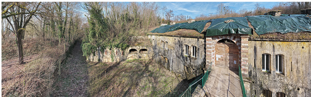
Gorge du fort et son bâtiment d'entrée. (vue aérienne).
