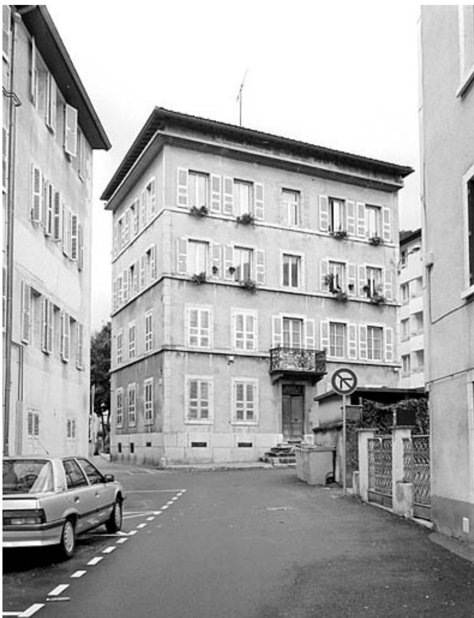
Elévation antérieure, de trois quarts gauche.
