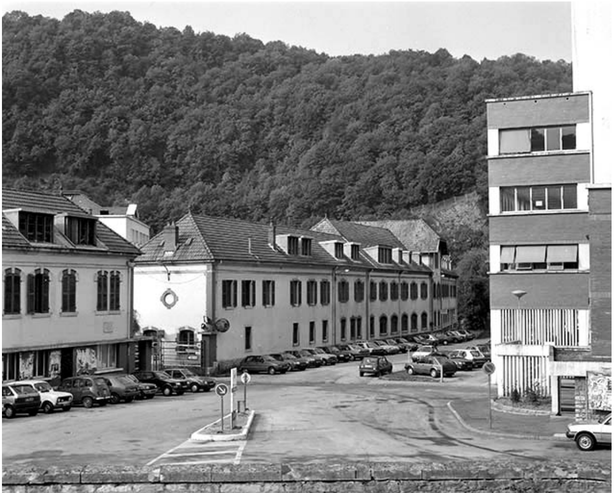
Façade sur rue des bureaux (M).
