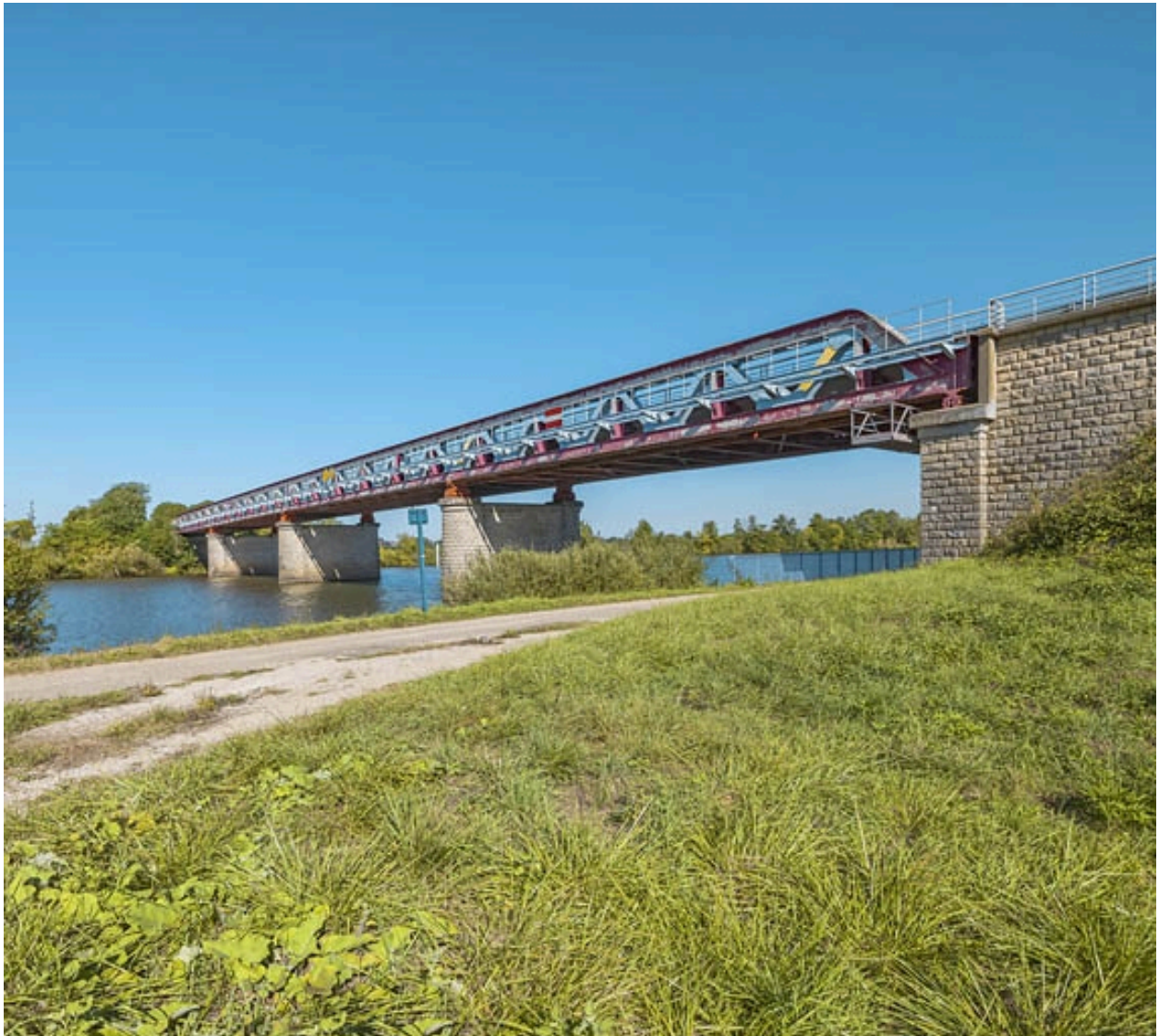
Vue d'ensemble du pont.
