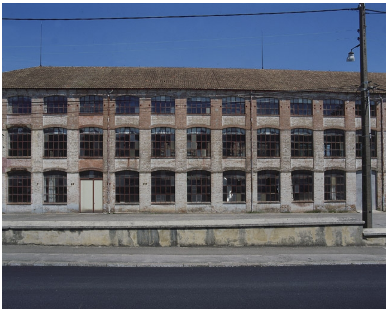
Travées de la façade sud.
