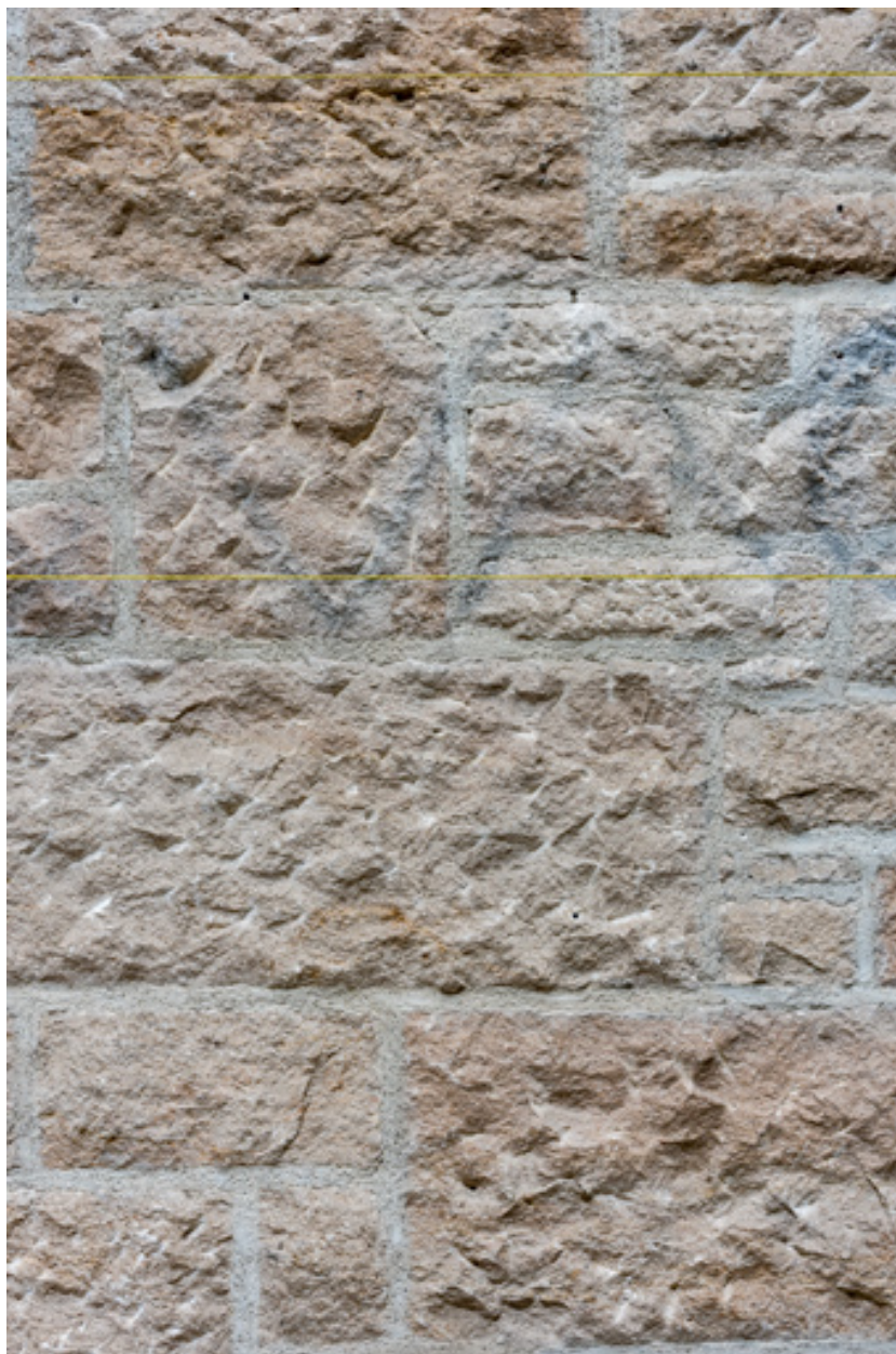
Maçonnerie du mur du chœur en appareil assisé. Détail.
