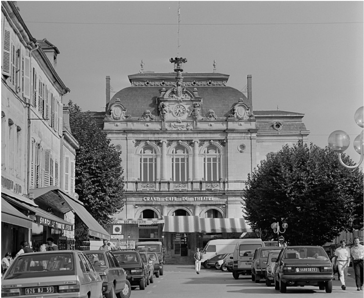
Façade antérieure, vue générale.
