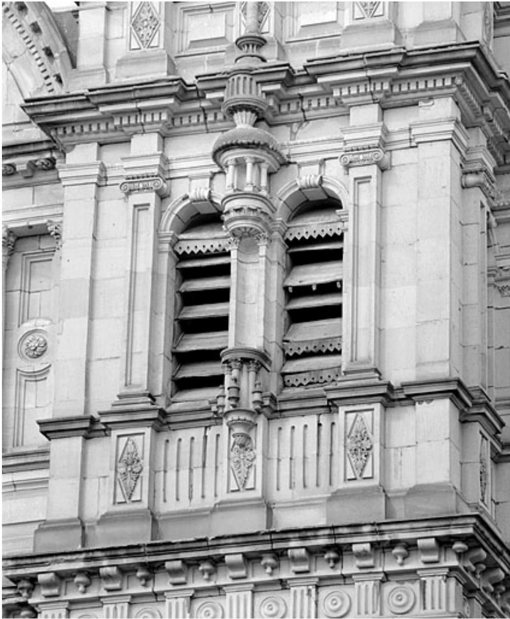
Deuxième niveau de la tour nord.
