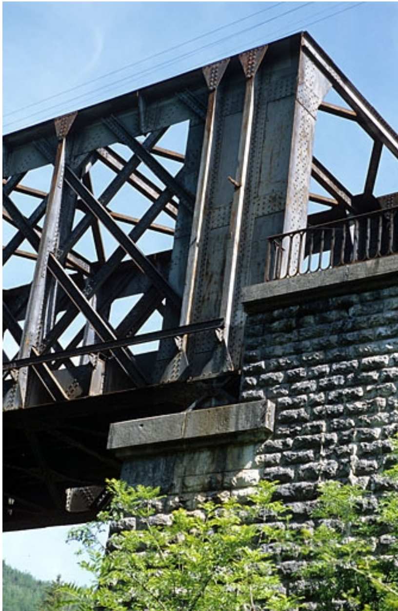
Extrémité côté Andelot-en-Montagne et culée, depuis l'amont : détail.
