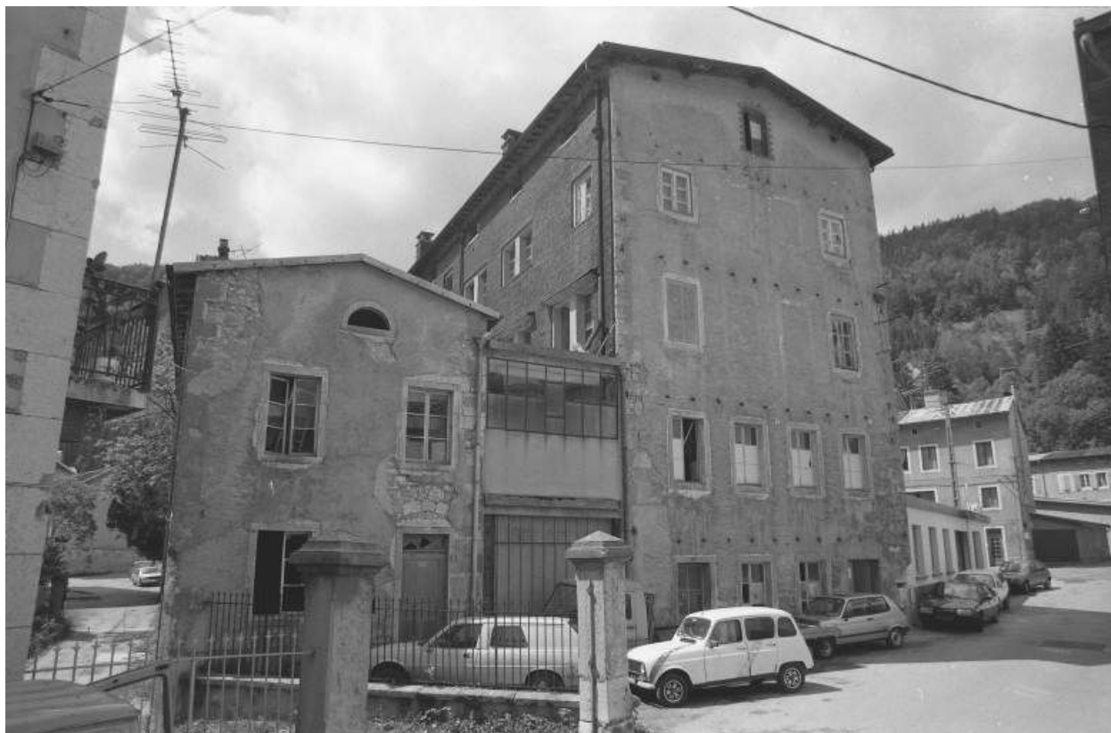
Bâtiment 6-8 rue Victor Poupin : façade latérale gauche.
