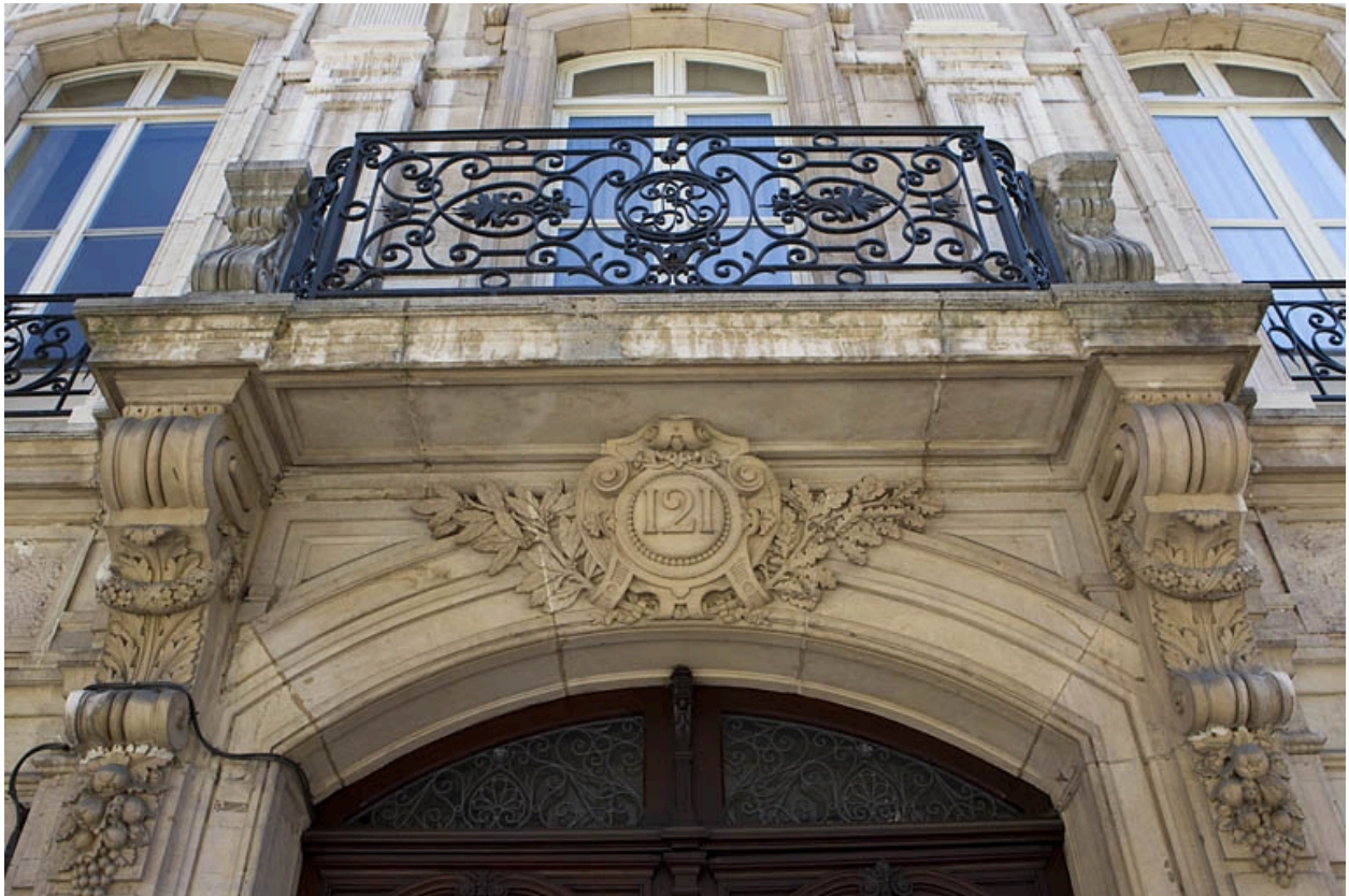
Façade antérieure, détail de l'arc du portail d'entrée et du balcon au-dessus.
