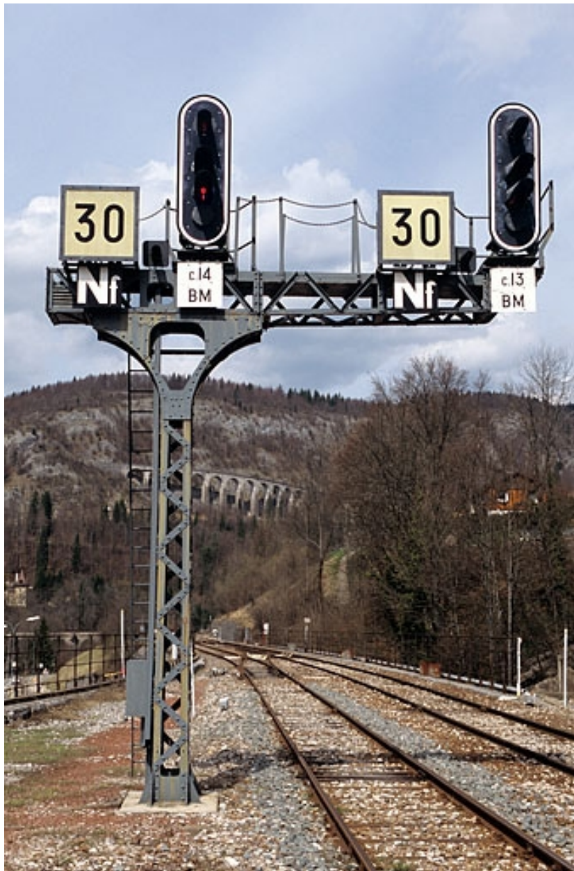
Vue d'ensemble rapprochée.
