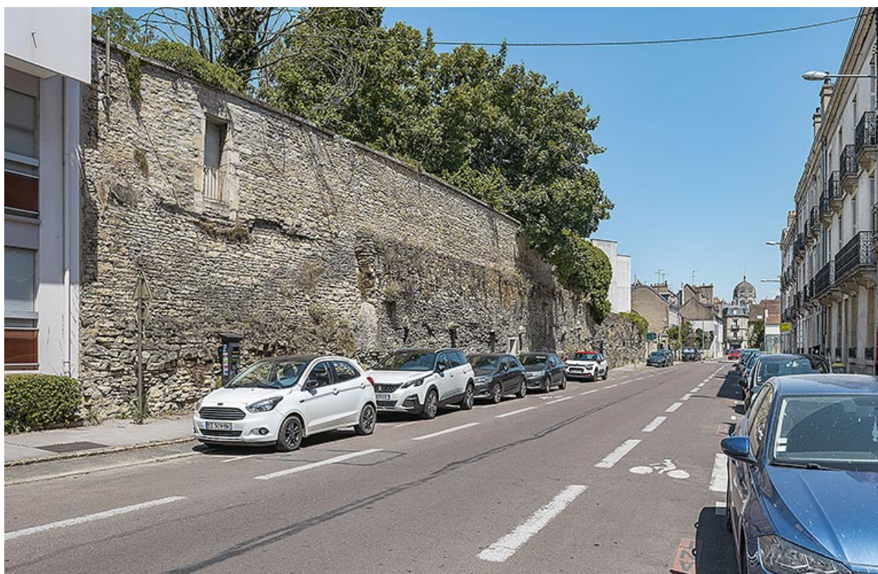
Le rempart subsistant, rue de Tivoli.
