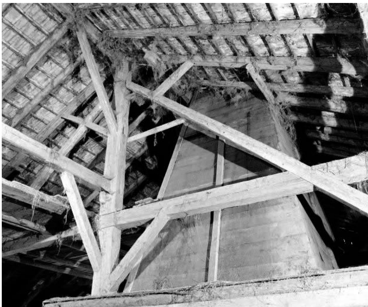
Intérieur : charpente et conduit du "tué".
