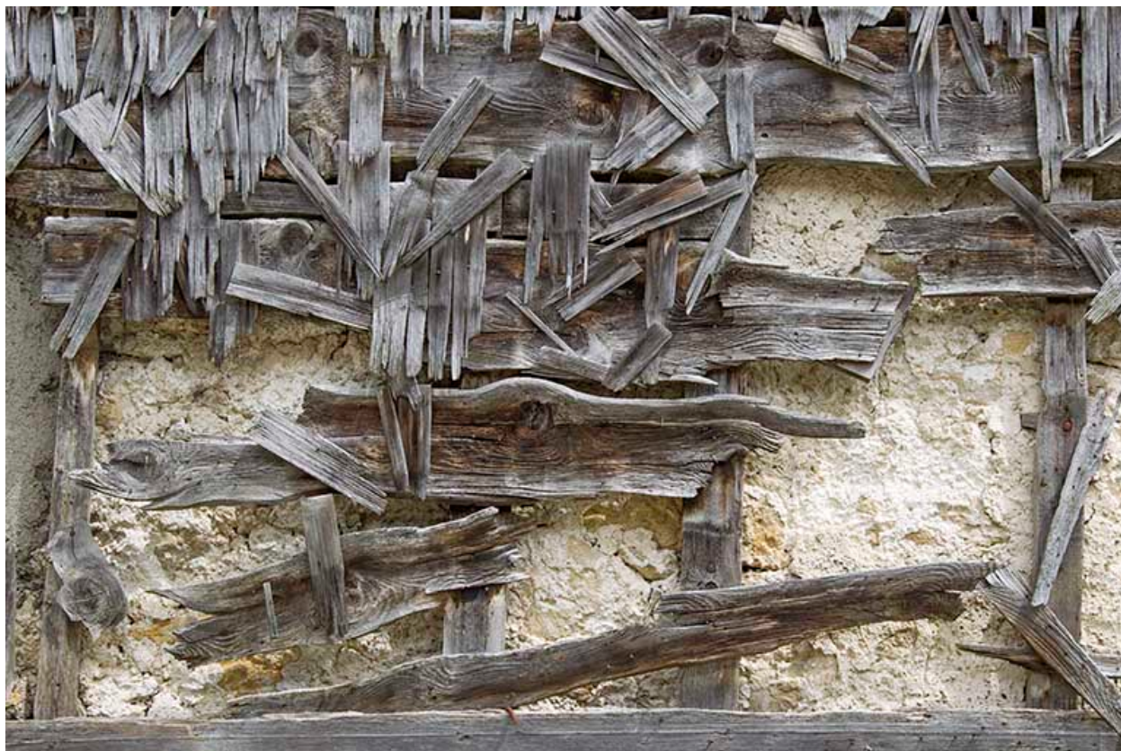
Façade postérieure : vestiges de l'essentage de tavaillons.
