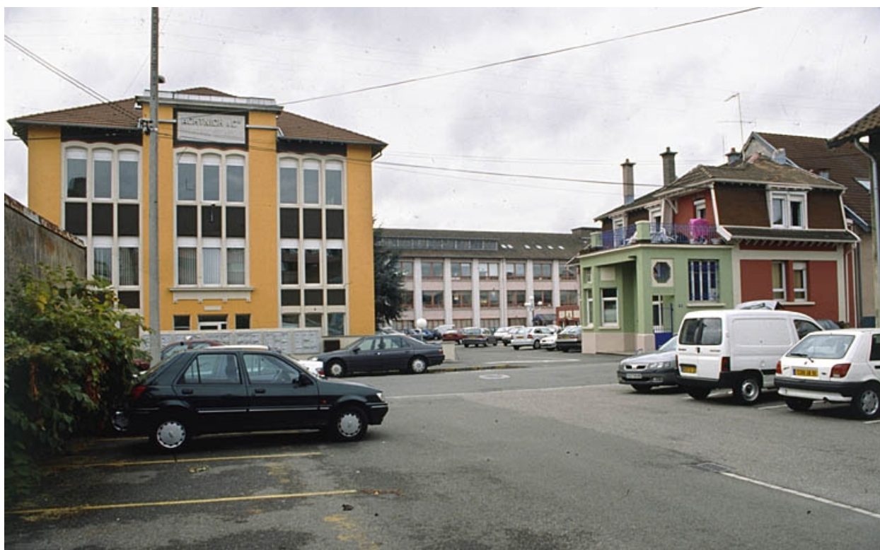
Vue de l'entrée depuis le nord.
