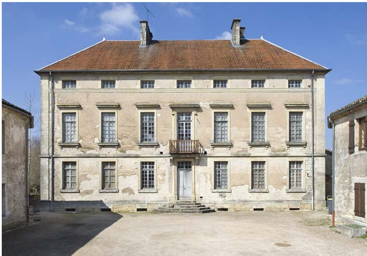
Logement patronal (31 rue Carnot). Façade antérieure.
