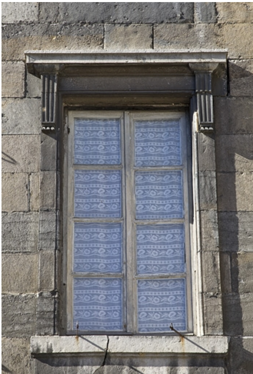
Aile droite : détail d'une fenêtre, de face.
