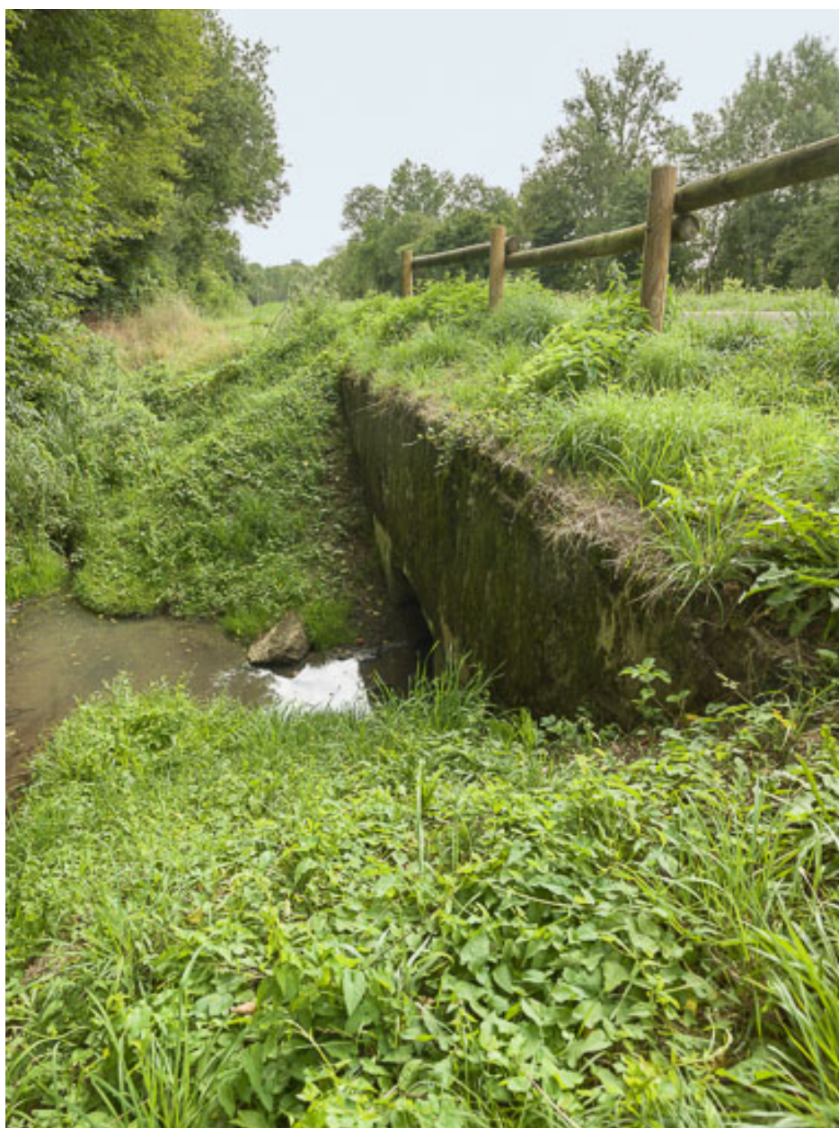
Vue de l'aqueduc.
