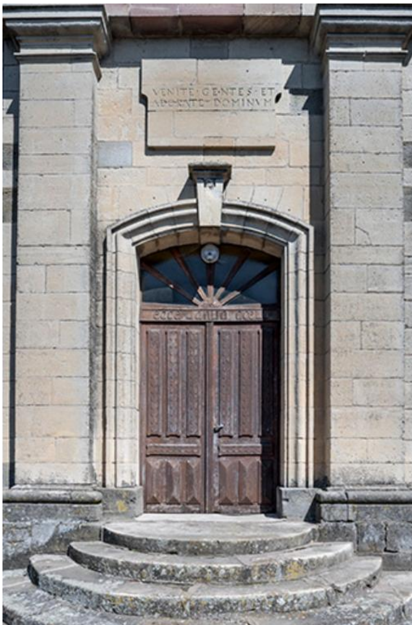
Portail d'entrée de l'église.
