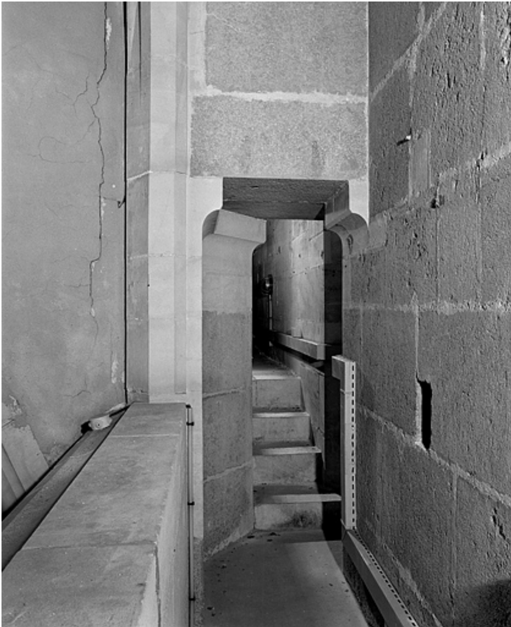
Vue de la coursière haute à la jonction du vaisseau central et de l'abside.
