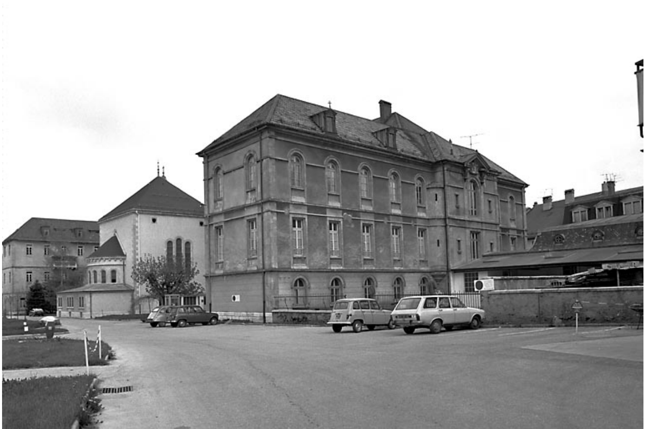
Façade postérieure, vue d'ensemble de trois quarts.
