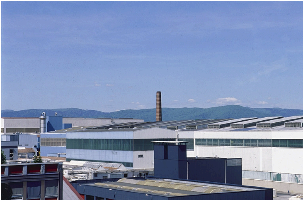
Vue des toitures depuis le sud.
